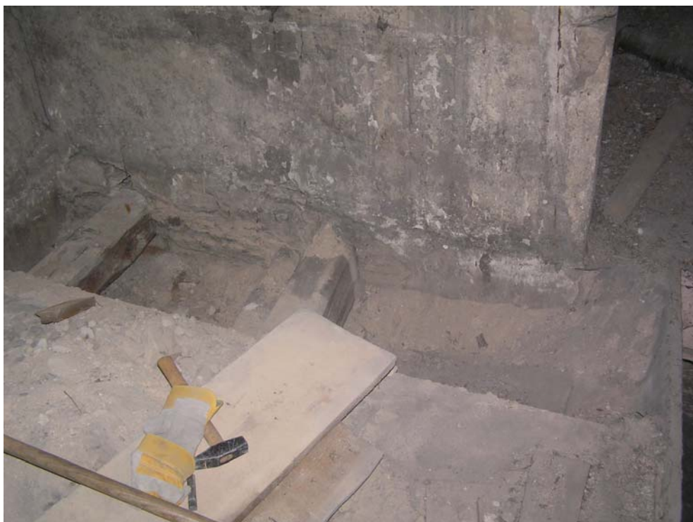
Foto 24: Sonda SS23, dřevěný trámový strop nad 2. patrem
