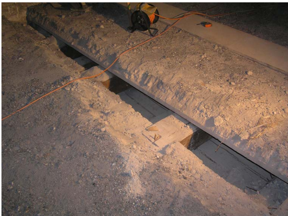
Foto 22: Sonda SS21, dřevěný trámový strop nad 2. patrem
