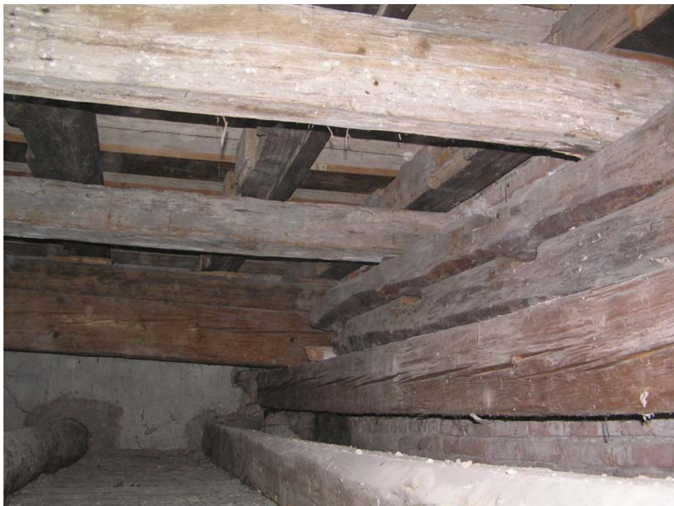
Foto 13: Sonda SS13, dřevěný trámový strop nad 1. patrem
