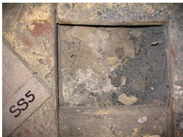
Foto 5: Sonda SS5 – klenba nad přízemím
