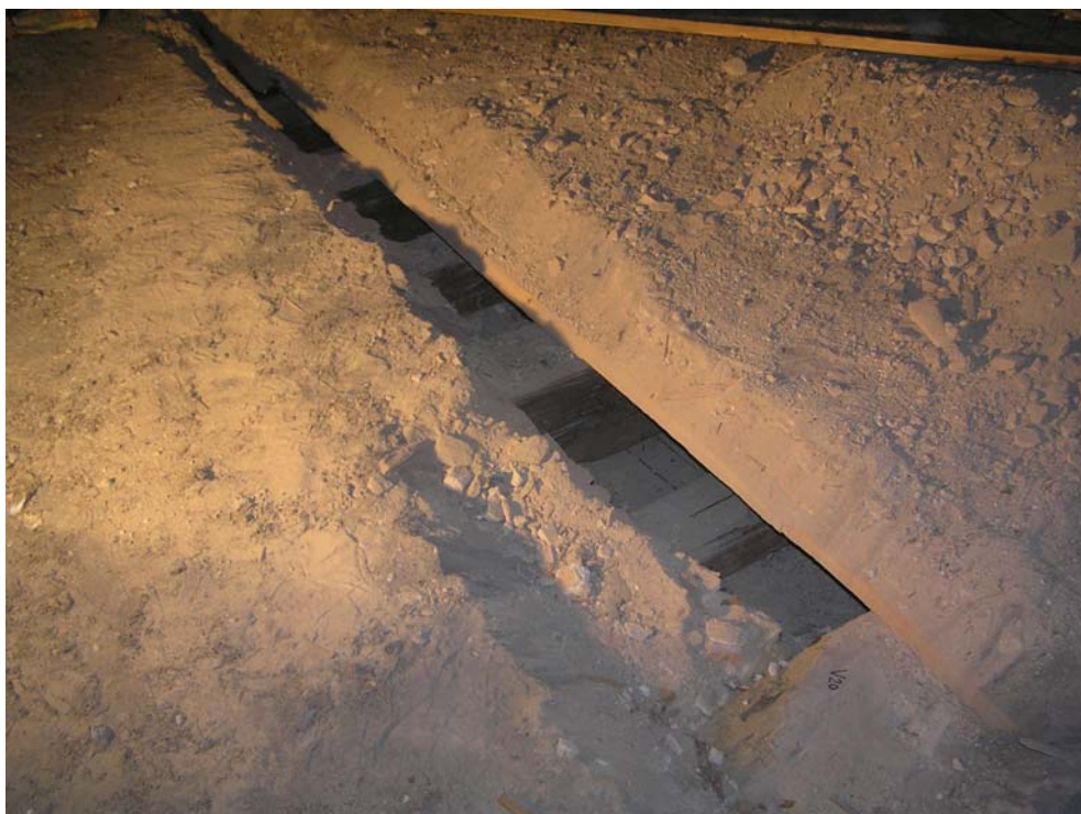
Foto 19: Sonda SS19, dřevěný trámový strop nad 2. patrem
