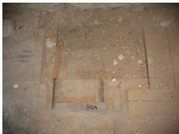
Foto 4: Sonda SS4 – klenba nad přízemím
