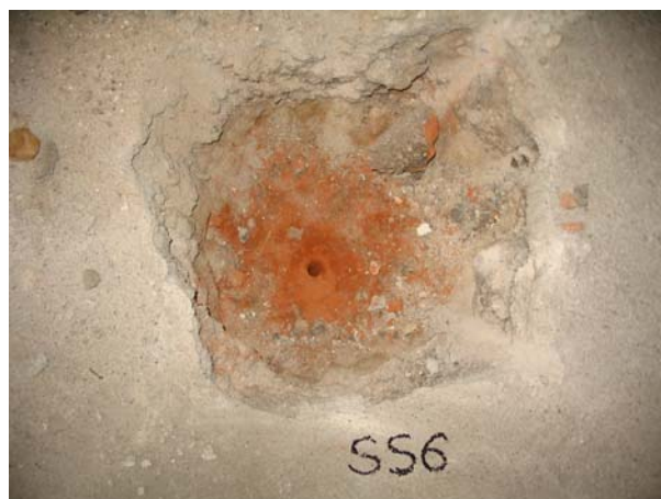
Foto 6: Sonda SS6 – klenba nad přízemím
