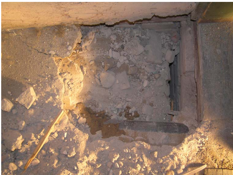
Foto 28: Sonda SS29, cihelná klenba nad 1. patrem (sonda provedena z úrovně podlahy)
