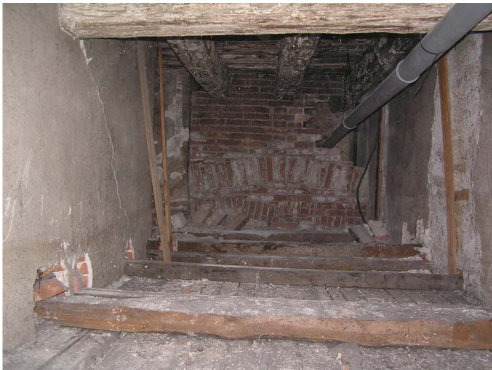
Foto 15: Sonda SS16, dřevěný trámový strop nad 1. patrem
