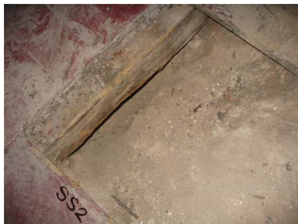
Foto 2: Sonda SS2 – klenba nad přízemím
