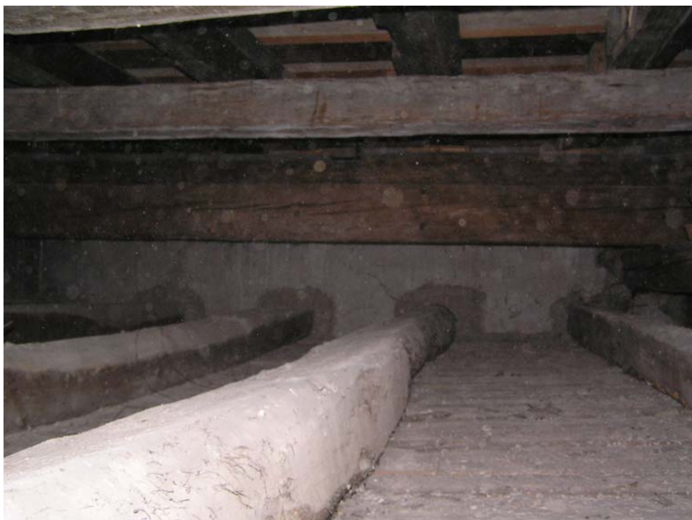
Foto 14: Sonda SS14, dřevěný trámový strop nad 1. patrem
