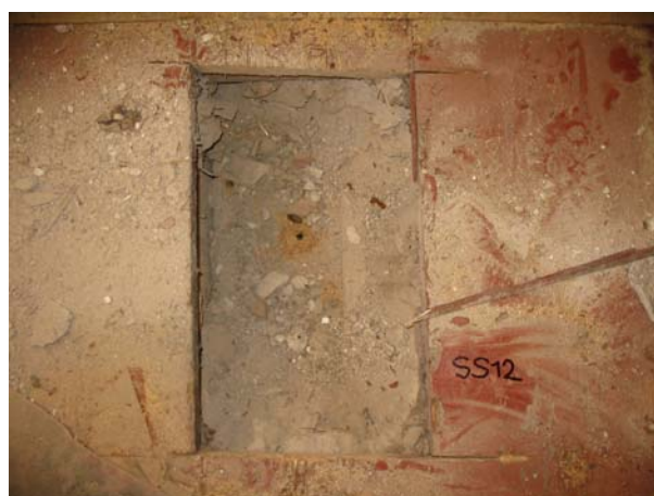
Foto 12: Sonda SS12 – dřevěný trámový strop nad 1. patrem
