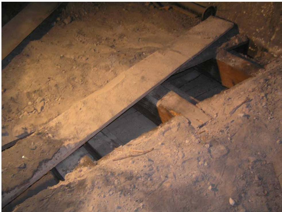
Foto 23: Sonda SS22, dřevěný trámový strop nad 2. patrem
