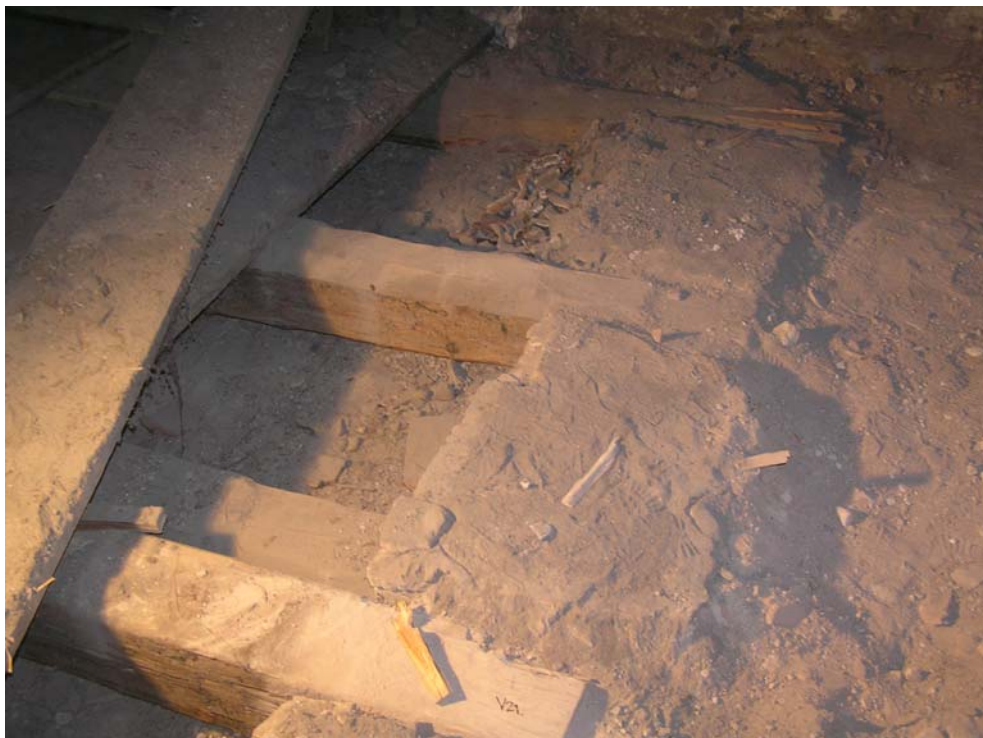
Foto 25: Sonda SS24, dřevěný trámový strop nad 2. patrem
