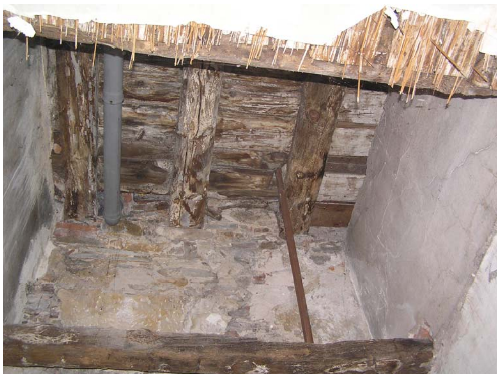
Foto 16: Sonda SS16, dřevěný trámový strop nad 1. patrem
