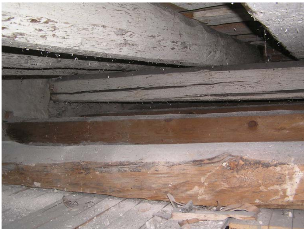
Foto 17: Sonda SS17, dřevěný trámový strop nad 1. patrem
