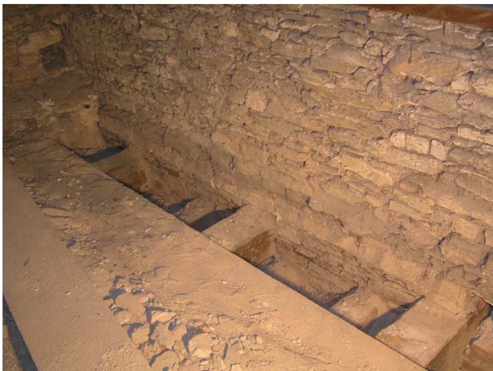
Foto 18: Sonda SS18, dřevěný trámový strop nad 2. patrem
