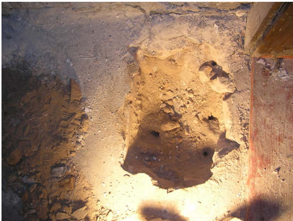
Foto 27: Sonda SS28, kamenná klenba nad přízemím (sonda provedena z úrovně podlahy)
