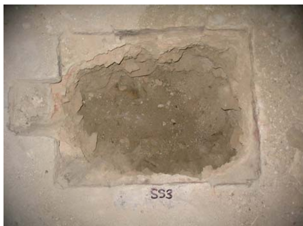
Foto 3: Sonda SS3 – klenba nad přízemím
