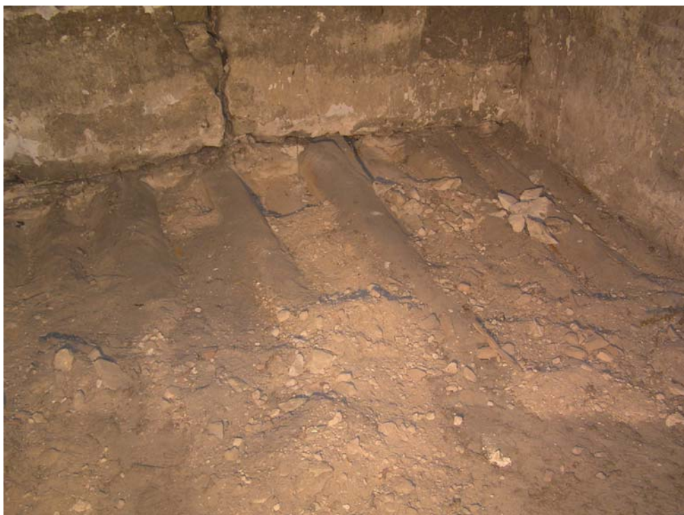
Foto 26: Sonda SS25, dřevěný povalový strop nad 2. patrem
