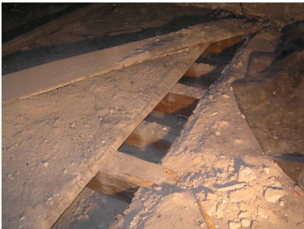
Foto 21: Sonda SS20, dřevěný trámový strop nad 2. patrem
