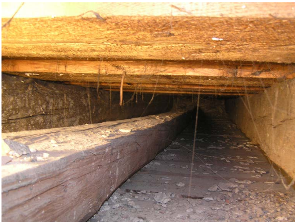
Foto 20: Sonda SS19, dřevěný trámový strop nad 2. patrem
